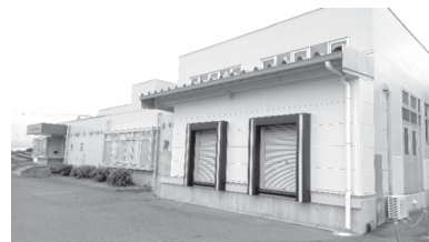
(ドックシェルター外観)
